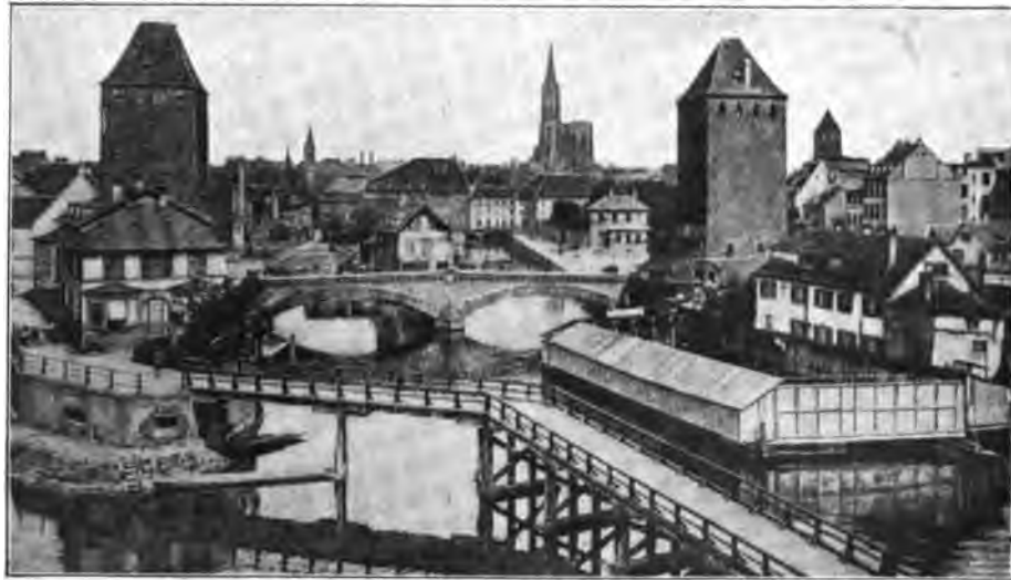
Les ponts couverts.
